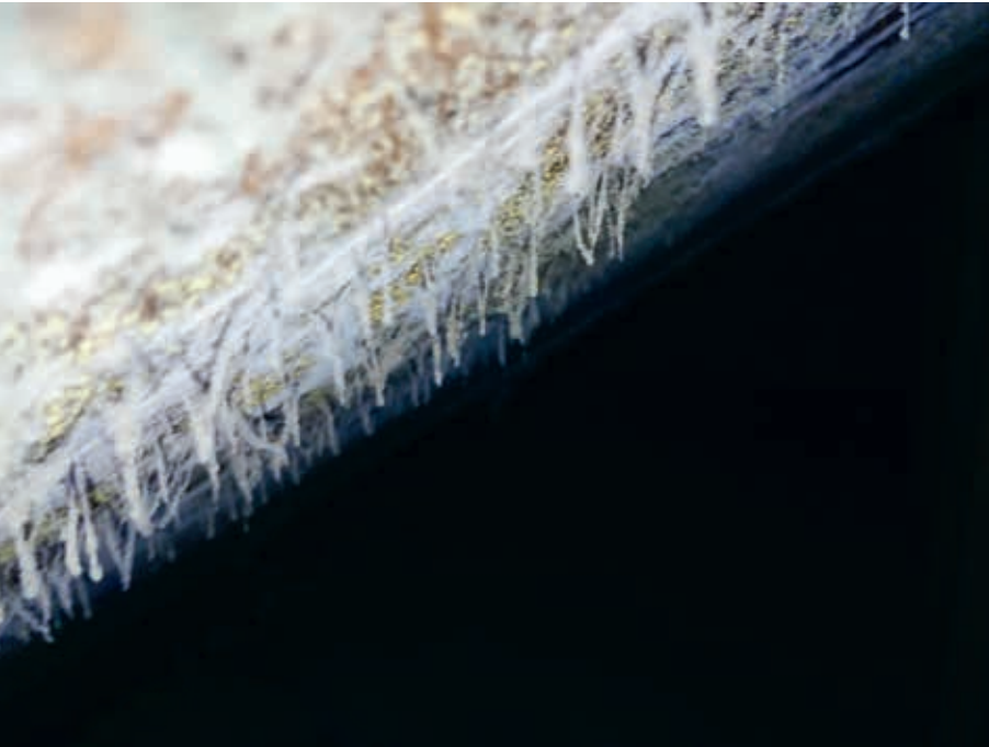
Afbeelding 6 en 7: schimmel op dakplaten achter knieschot.
