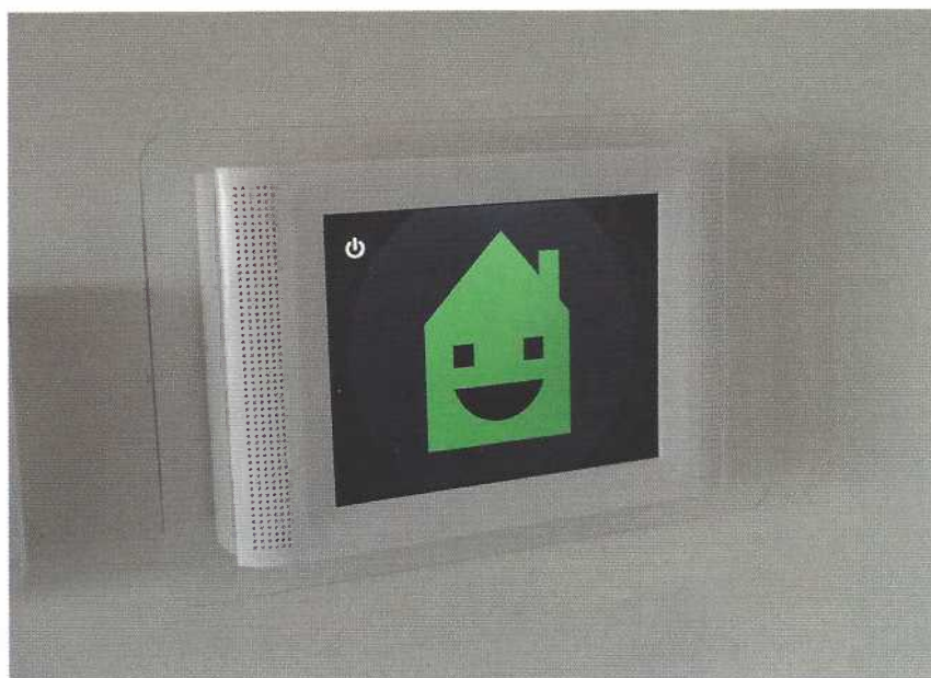
△ Sensoren en een display in de woonkamer die met een smiley aangeeft of de luchtkwaliteit in de woning goed is. Op die manier wordt het voor de bewoner eenvoudig inzichtelijk.
