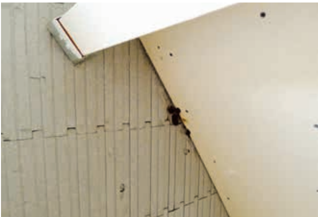
Dit is "The Big mama": door een verwaarloosde daklekkage veroorzaakt. Ook gratis; herstelkosten inclusief saneren ruim € 10.000,-
