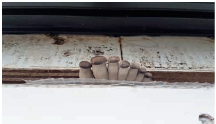
Dit is "The Adams Family": door een gebrekkig aangebrachte waterkering rondom de kozijnen in de spouw ontstaat capillair vochttransport. Deze zijn ook gratis; herstelkosten zijn echter € 1.500,-
